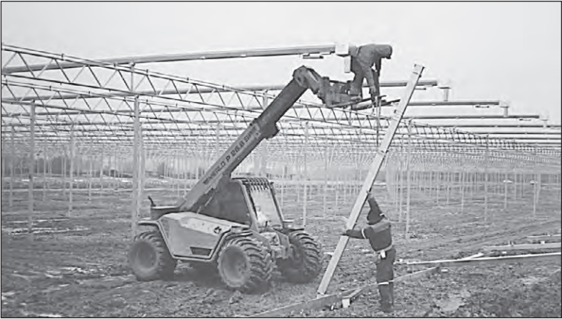
Mit Hochdruck wird an der Großgärtnerei bei Beuren gearbeitet. Mitte Februar soll mit der Produktion begonnen werden. swb-Bild: wf
