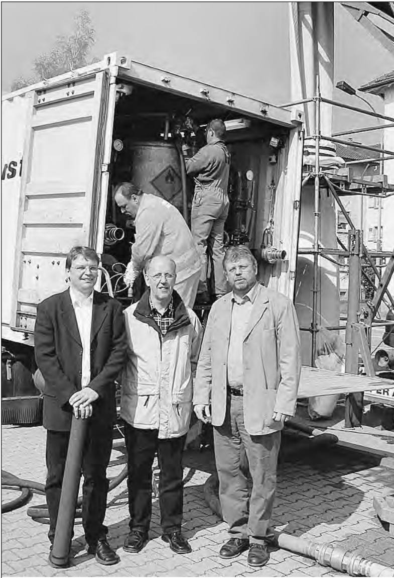
Wolfgang Weber von der Stadtwerke-Abteilung „Abwasser“ (Mitte) erklärt gemeinsam mit Vertretern der Firma Institutform das moderne Kanalsanierungsverfahren, das momentan in Singen angewandt wird.
