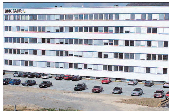
Das BKK-Gebäude wurde um zwei Stockwerke erweitert.
