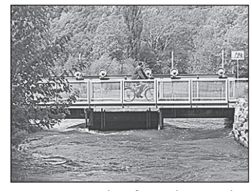
Das Wasserkraftwerk an der Singener Musikinsel wurde reaktiviert.
