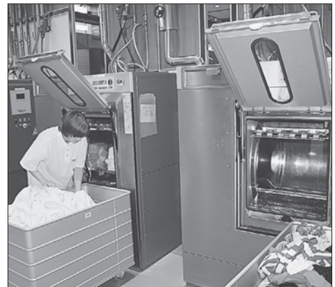
Hier werden die großen Waschmaschinen mit Schmutzwäsche befüllt. Auf der anderen Seite der Wand wird dann die saubere Wäsche weiter bearbeitet.
