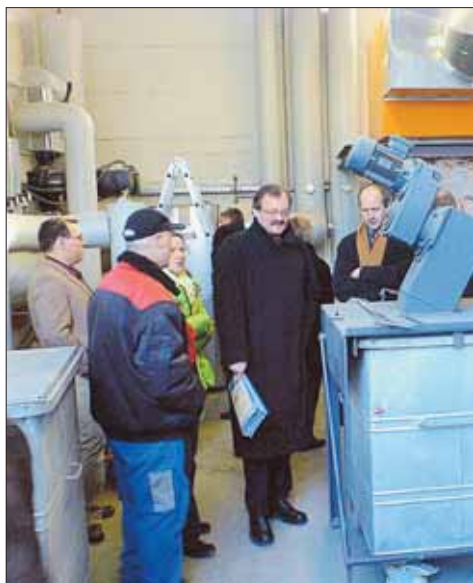
Geschäftsführer Axel Nieburg erläutert den Wärmelieferanten die Funktionsweise der Holzhackschnittelheizzentrale.
