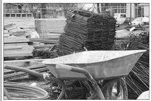
...von der Stadthallen-Baustelle.
