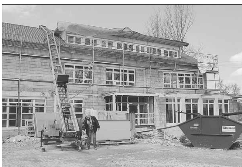
Der Neubau beherbergt Schule, Kindergarten, Küche, Speisesaal und Verwaltung. Uwe Rump vom Förderverein »Haus Höri« schaut während der Bauzeit nach dem Rechten.
