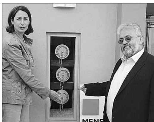
Schulleiterin Ulrike Armbruster und Klaus Müller, Projektleiter der städtischen Abteilung „Gebäudemanagement“, zeigen auf die zwei Füllungen und eine Entlüftungsleitung der neuen Pelletheizung in der Schillerschule.
