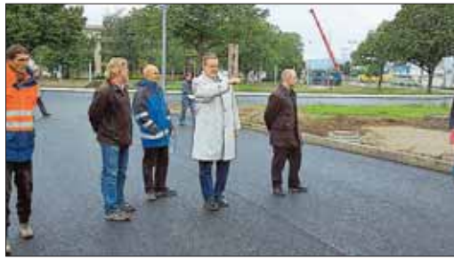
Ortstermin an der Baustelle im »Steißlinger Kreisel«, wie am Freitag bekannt gegeben wurde, soll der Kreisverkehr nun bereits einen Monat früher, als Ende Juni, wieder befahrbar sein. swb-Bild: of
