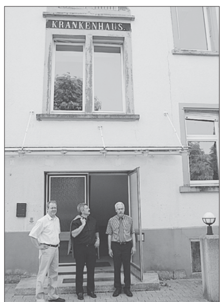
Die Tage des alten Krankenhauses in Blumenfeld sind gezählt. Die Verbandsversammlung (von links) mit den Bürgermeistern Hengster (Geissingen), Baumann (Blumberg) und Groß (Tengen) beschloss den Abriß des maroden Gebäudes.
