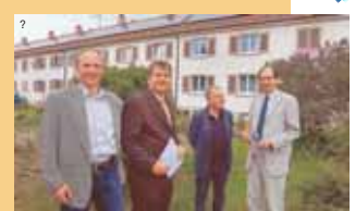
Jüngstes Beispiel für die Umsetzung ökologischer Ziele der GVV ist das Solarkraftwerk in der Singener Umlandstraße.
