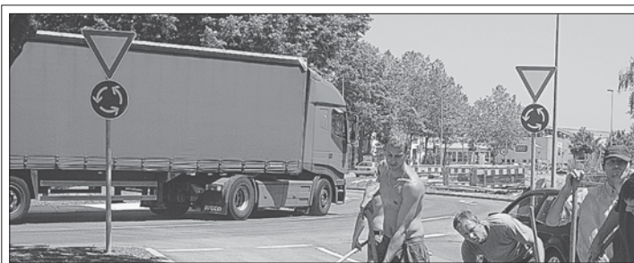
Wieder freie Fahrt in Singens Süden: am Freitag wurde der neue Kreisell an der Georg-Fischer-Straße/Steiflinger Straße nach mehrmonatiger Vollspernung durch Umbauarbeiten zum »echten« Kreisverkehr wieder für den Verkehr freigegeben. Die Verkehrsöffnung konnte durch den guten Fortschritt der Bauarbeiten einen Monat früher als zunächst geplant erfolgen.
