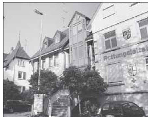
Das Rettungszentrum in Radolfzell wird für 3,2 Millionen Euro umgebaut und durch das Nebengebäude (links) erweitert. Damit sind die bisher gehegten Neubaupläne an der Radolfzeller Lohrampel erledigt. swb-Bild: pud
