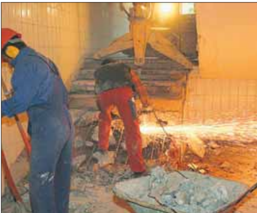
Derzeit stieben die Funken am Hegau-Gymnasium. Die Arbeiten für die Erweiterung beginnen mit dem Rückbau des Treppenhauses. Bauleiter Jürgen Wick hatte diese Treppen 1960 noch als Maurerlehrling eingebaut. Nun reißt er sie ab. swb-Bild: cb
