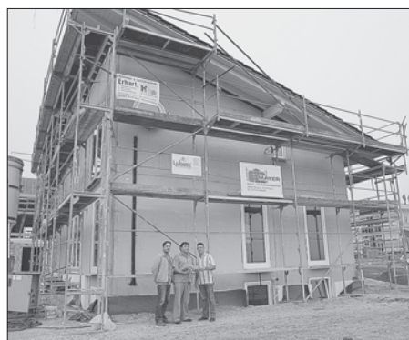
Ein modernes Pultdach für ein Haus, das dank vorgefertigter Betonelemente weniger als vier Wochen Rohbauzeit benötigt.
