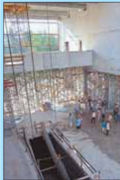
Tolle Einblicke bot die neue Stadthalle Singen am Samstag beim Baustellenfest. Seite 3
