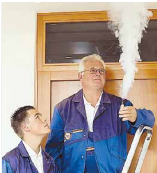
Für eine effektive künstliche Belüftung muss das Haus dicht sein. Das wird vom Handwerker mit künstlichem Rauch kontrolliert.
