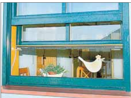
Sieht aus wie ein Fenster, ist ein Fenster aber lässt Einbrecher verzweifeln: das Schiebefenster als neue Entwicklung, swb-Bild: Sorpetaler
