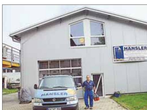
Solide Investition in die Zukunft: die erst vor fünf Jahren gebaute Halle der Firma Hänsler im Mooser Gewerbegebiet bietet ausreichenden Platz für alle Arbeiten. swb-Bild: pud
