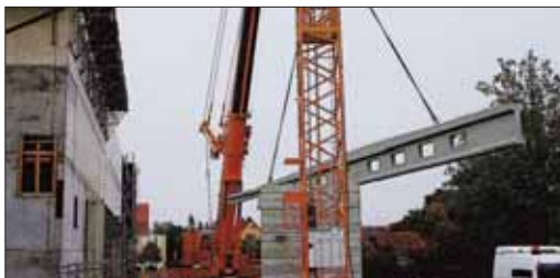
50 Tonnen und 35 Meter Länge sind die Maße eines der 5 Dachbinder swb-Bild frö
