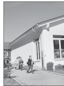
Der neue Anbau der »Sonnenlandschule« in Stockach wurde für Gesamtkosten in Höhe von etwa einer Million Euro fertig gestellt. swb-Bild: Weiß
