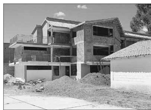
Das Schlafgebäude des »Haus der Freundschaft« im peruanischen Sicuani schaut seiner Vollendung entgegen. Ist es fertig, kann der Betrieb aufgenommen werden. Dass das Projekt realisiert werden konnte, daran hatte die Markelfinger Kirchengemeinde einen großen Anteil. swb-Bild: Birgit Bayer
