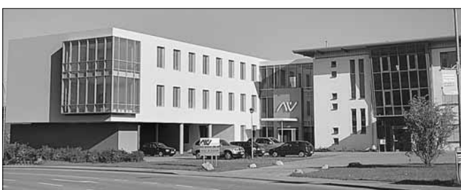
Die Stockacher Firma »Nissen & Velten« ist komplett in ihren neuen Anbau umgezogen.
