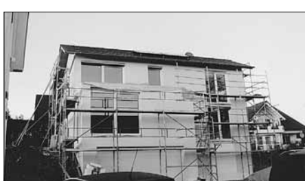
Kurz vor der Vollendung ist dieses Passivhaus in Mauenheim.
