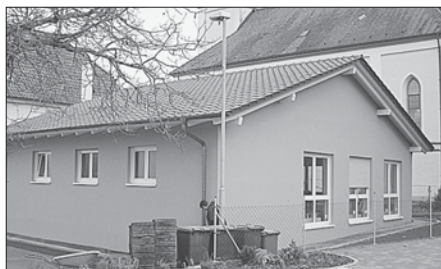
Der fertige Bau, auf den die Überlinger so stolz sind. swb Bilder: Architekturbüro Hein
