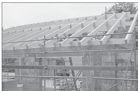
Schon war das Dach fast fertig...
