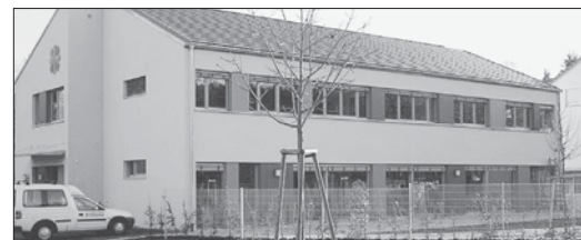
Ansprechende Architektur, der neue Caritas-Bau St. Teresa.
