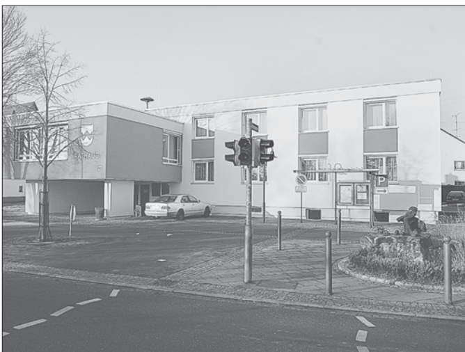
Grundlegend saniert wurde das Rathaus in Volkertshausen in rund dreimonatiger Bauzeit. Neben der neuen Farbgebung ist das Dach nun wieder dicht und das Gebäude verbraucht viel weniger Energie zum beheizen. swb-Bild: of
