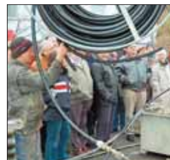
Die Erdwärmesonde der Wärmepumpe ist installiert. swb-Bild: aj
