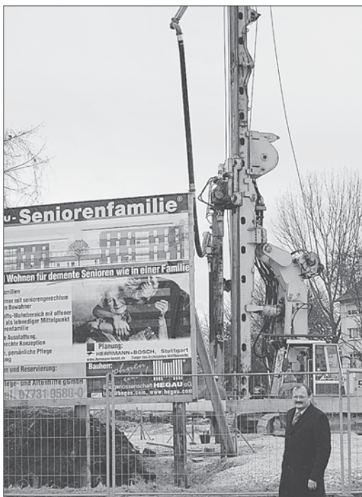
Hier wurde mit hoher Präzision gebohrt, auf dem Gelände in der Singener Südstadt entsteht eine Seniorenwohnanlage.
