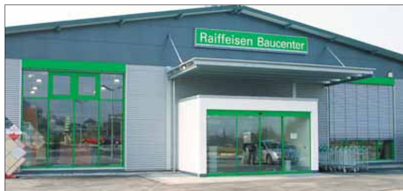
Das neue Raiffeisen Baucenter der ZG in Mühlhausen-Ehingen.
