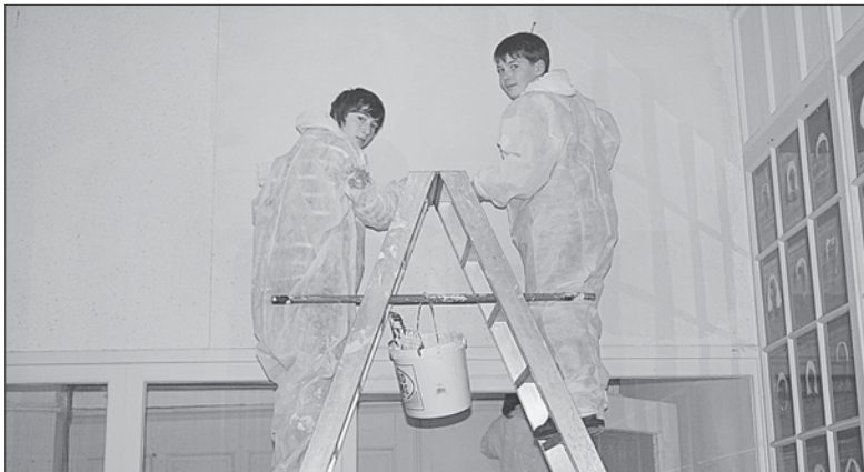
Insgesamt 48 Jugendliche engagierten sich bislang an der Renovierung des Jugendtreff »Juca 60« in Rielasingen-Worblingen. Der Treff wird im Zuge der Arbeiten auch vergrößert. swb-Bild: pr
