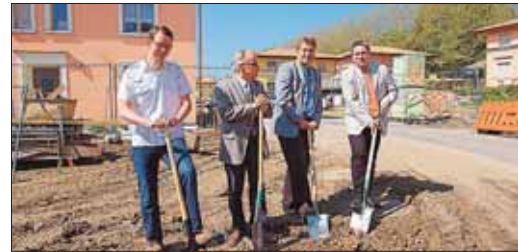
Der Spatenstich konnte am Freitag in der Sommerfrische Arlen bei der GVV gefeiert werden. Im Bild links Architekt Daniel Binder, Aufsichtsrat Johannes Matern, GVV Geschäftsführer Roland Grundler und Bürgermeister Ralf Baumert beim Spatenstich für ein Reihenhaus.
