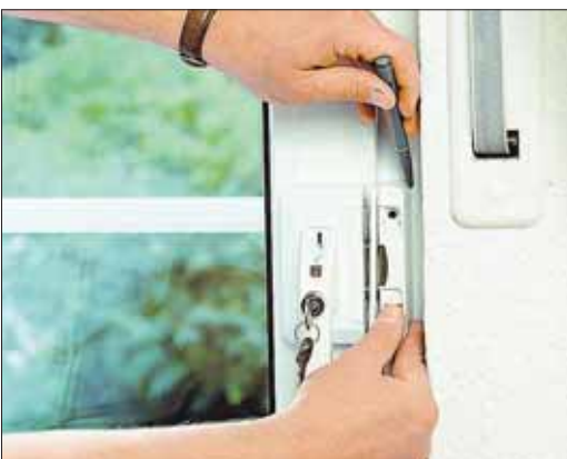
Durch den nachträglichen Einbau von Sicherungstechnik wird der Einbruchschutz deutlich erhöht. swb-Bild: ABUS
