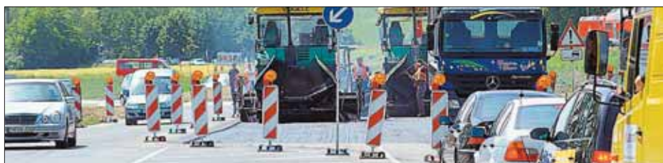
Auf vollen Touren wird derzeit noch gebaut an der Nordumfahrung.
