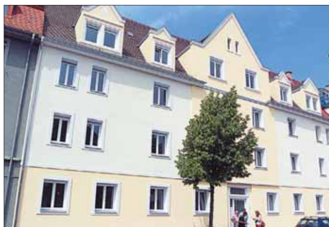
Eine Oase mitten in der Innenstadt. Die GVV saniert das Haus Ekkehardstraße 97 in Singen. swb-Bild: frö
