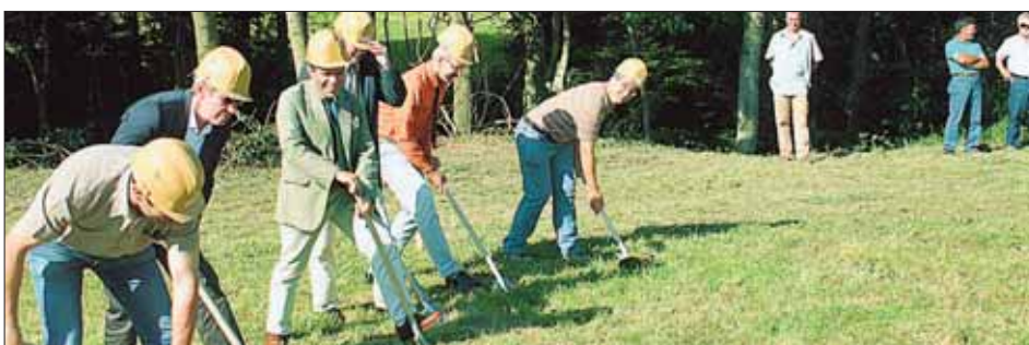
Hier wird der Hochwasserschutzdamm gebaut: Bürgermeister Artur Ostermaier freut sich darauf.
