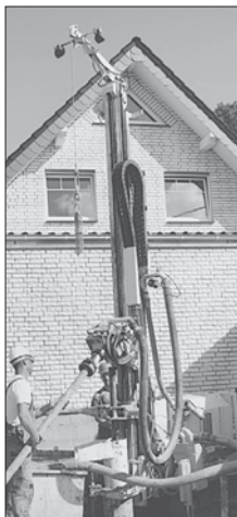
Eine von elf Geowell-Bohranlagen im Einsatz für eine Sole/Wasser-Wärmepumpe.
