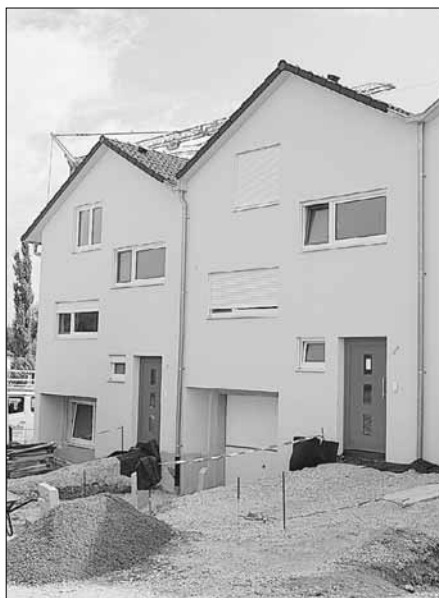
Im ersten Bauabschnitt entstanden diese Reihenhäuser, die bereits bewohnt sind. swb-Bild: aj
