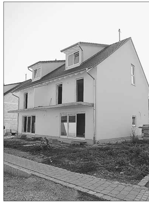
In Eigeltingen entstehen derzeit zwei Doppelhäuser des Unternehmens Wägeler aus Singen-Schlatt. Das bereits verkaufte erste Gebäude ist bis Dezember bezugsfertig, das zweite wird im Frühjahr fertig.
