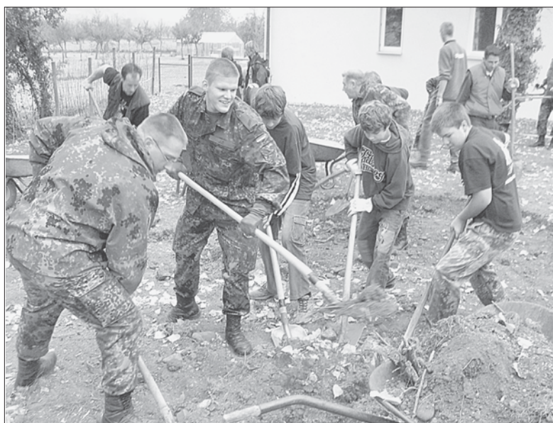
Teamwork: Reservisten und Jugendliche bei Aushubarbeiten für den neuen Kinderspielplatz der Heimsonderschule am Mühlebach in Mühlhausen-Ehingen.
