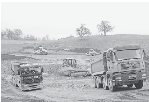
Großbaustelle Hochwasserrückhaltedamm: Hier staut sich vieles.
