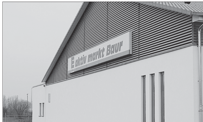
Nach sechs Monaten Bauzeit wird morgen, 6. Dezember der neue Edeka Aktiv Markt Baur in der Dietlishoferstraße in Hilzingen eröffnet.
