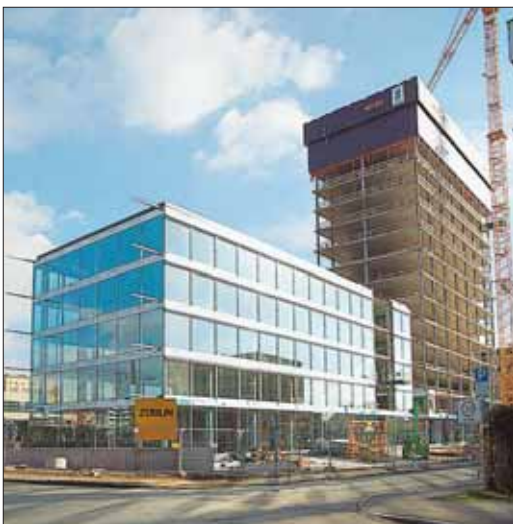
Bereits alles unter Glas ist im vorderen Trakt des Hegau-Towers. Aber erst im März soll das Richtfest gefeiert werden, wenn es keinen Nebel mehr gibt wie beim ersten Spatenstich swb-Bild: of
