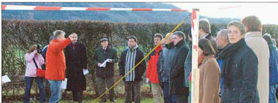
So hoch wird das Gelände auf dem Worblinger Bad künftig liegen. Planer Henry Gutmann (im roten Kittel) gibt vor Ort Orientierungszeichen. Für die Gemeinderäte liegt diese Maßplatte mehrheitlich zu hoch. Das wurde bei der Beratung im Gemeinderat deutlich. Jetzt geht es wieder in den Ausschuss. swb-Bild: li
