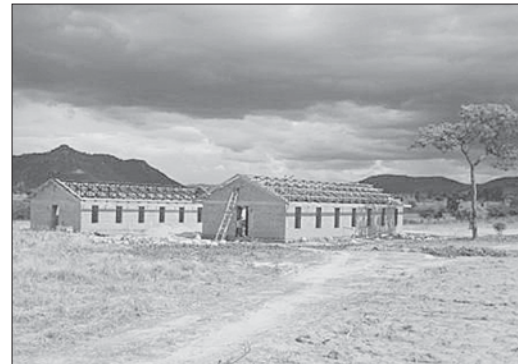
Die Regenzeit ist angebrochen in Tansania. Rechtzeitig konnte das Dach für die Mädchenschule der »Brücke der Freundschaft« aufgebracht werden.
