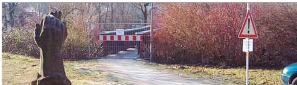
Sie ist bis auf weiteres gesperrt, die Fußgängerbrücke bei der »Alten Mühle«.
