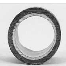
Am Schluss der Sanierung wird eine neue Rohrinnenfläche eingebracht. swb-Bild: D&D
