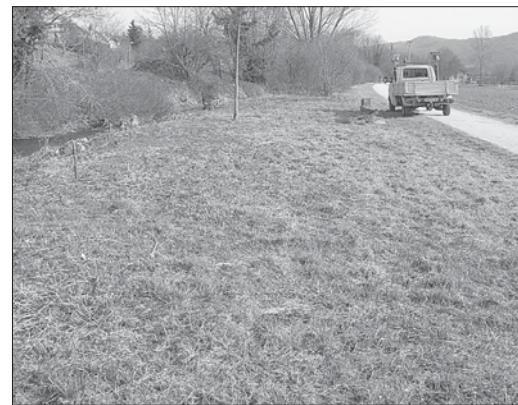
Im Bereich Oberwiesen wird der Lauf der Aach in diesen Tagen per Bagger renaturiert. Damit werden auch Flusslebenszonen geschaffen. swb-Bild: Gemeinde
