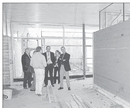
Außen Beton, innen Lehm. Für die neue Mensa der Hardtschule wird eine besondere Bauweise mit gestampften Lehm im Innenbereich eingesetzt. Nach den Pfingstferien soll die Mensa für 230 Schüler ihren Betrieb aufnehmen. swb-Bild: of
