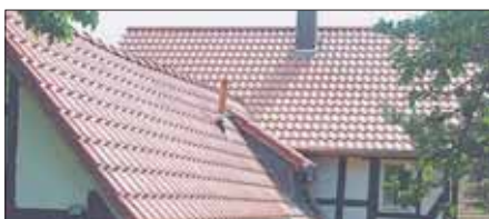
Eine Dachsanierung trägt erheblich zum Werterhalt des Gebäudes bei - und hilft eine Menge an Energie einzusparen. swb-Bild: laumanns
