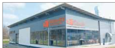
So sieht das neue Oberflächenzentrum an der B 34 aus.
