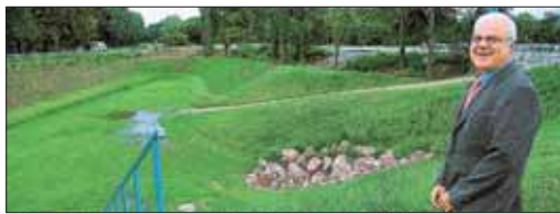
Michael Hohner, Leiter der Technischen Betriebe bei Alcan Singen, stellte am Dienstag die neue Regenwasserversickerungsanlage vor.
