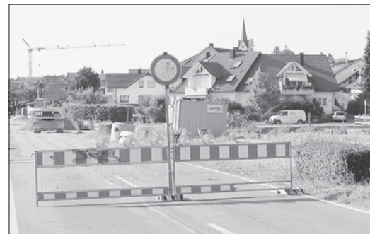
»Geschlossen« ist Steißlingen zur Zeit an der Hauptzufahrt aus Richtung Radolfzell. Bis Ende Oktober dauern die gesamten Bauarbeiten an. swb-Bild: le
