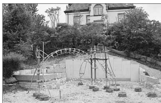
Wieder ein Stück geschafft: Am vergangenen Donnerstag wurde das Klettergerüst für den Aacher Schulhof geliefert und aufgebaut. swb-Bild: privat
