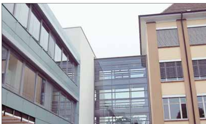
Der neue Anbau von der Westfront aus gesehen.
