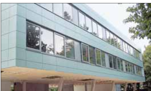
Ein Teil des neuen Anbaus von der Ostseite aus gesehen.
