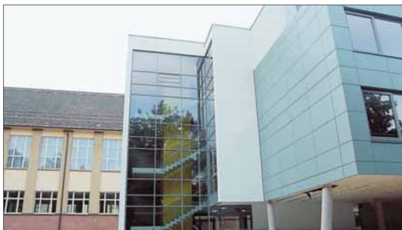
Der Anbau des Hegau-Gymnasiums steht unmittelbar vor der Fertigstellung. Hier die Ansicht von der Nordseite.
