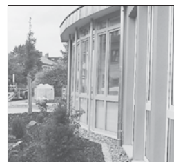
Auch um das Bürgerhaus wurde die Außenanlage geschmackvoll angelegt.
