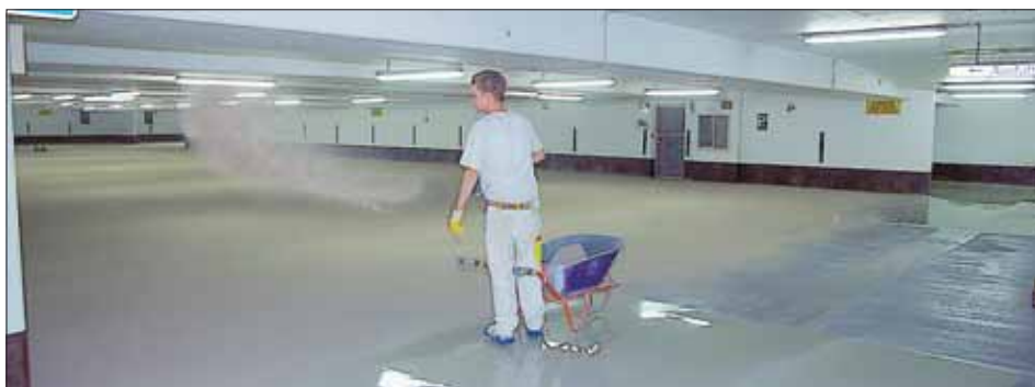
Derzeit wird das Parkhaus am Heinrich-Weber-Platz saniert. Die Stadtwerke als Eigentümer des Objekts müssen hier Wasserscheiden beseitigen, hoffen durch die Aufhellung aber auch auf eine stärkere Parkfrequenz.
