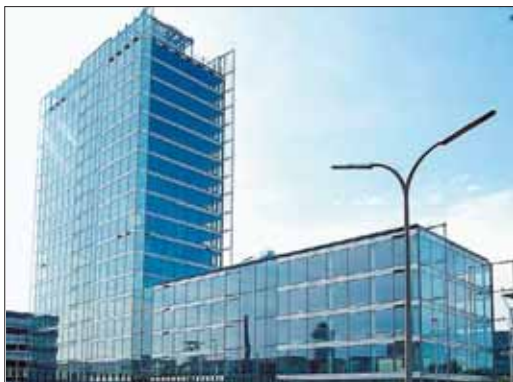
Vor seiner Vervollständigung steht der Hegau-Tower in Singen nach 18 Monaten Bauzeit. Vom 10. bis 12. Oktober wird die Einweihung groß gefeiert.
