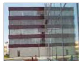
Architekt Helmut Jahn hat mit der Gläsernen Oberfläche ein Gebäude geschaffen, das sich ständig verwandelt.
