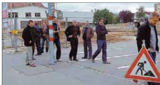
Begonnen hat der Bau für das neue Plana Küchenland mit künftig 800 Quadratmeter Ausstellungsfläche. Im Frühjahr soll Einweihung an der Georg-Fischer-Straße gefeiert werden können. Im bisherigen Gebäude soll dann ein Bettengeschäft einziehen. swb-Bild: of
