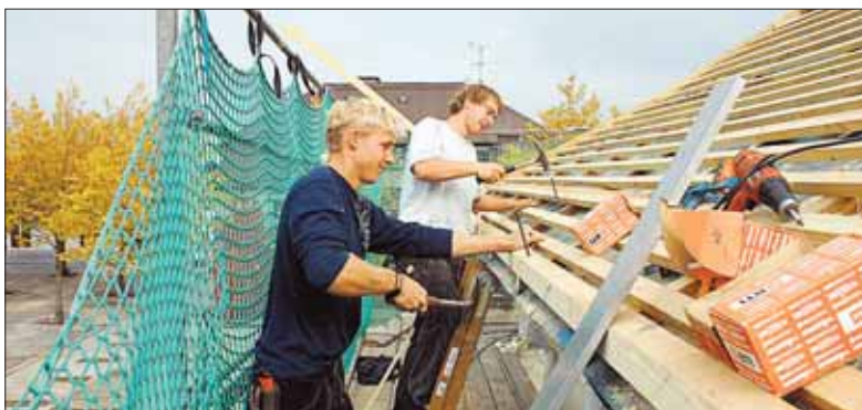
Eines der aktuellen Projekte der Firma Zimmerei + Holzbau Hirling ist das Haus in der Güttinger Straße, in dem das Kulturamt war. Steven Scholter und Florian Mahlbacher (v.l.) sind dabei der Kultur »auf das Dach gestiegen«.
