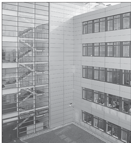
Im Innenhof des neuen Gebäudes der BKK Fahr in Gottmadingen wird eine Außenfläche für das neue Betriebsrestaurant genutzt, das Ende des Monats seinen Betrieb aufnehmen soll. Es wird von Sternekoch Michael Sobota von den »Salzburger Stuben« aus Worblingen unter dem Namen »MiCa« betrieben.
