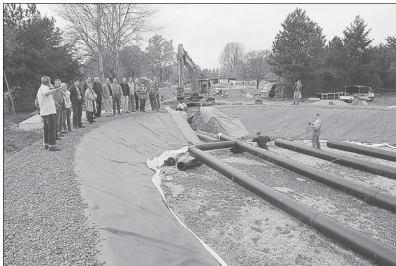
Weit fortgeschritten sind die Erdarbeiten für das neue Naturbad in Worblingen. Der Projektausschuss nahm letzten Mittwoch die Planung für das neue Empfangsgebäude unter die Lupe. swb-Bild: of
