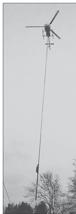
Mit einer »fliegenden Säge« und einem Hubschrauber wurden Äste in der Nähe von Spannungsleitungen abstrahlt.
