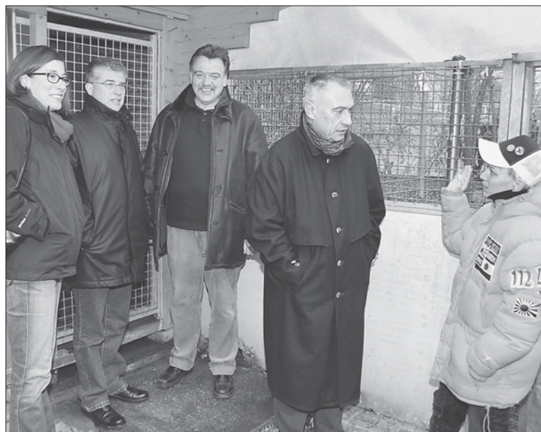
Das Tierschutzheim Radolfzell befindet sich baulich in einem desolaten Zustand. Aus Gründen der Tierhygiene und der artgerechten Unterbringung ist ein Umbau dringend notwendig. Davon überzeugten sich Stadträtin Cornelia Bambini-Adam, MdL Andreas Hoffmann, Tierschutzverein-Vorstand Hans Weber, Stadtrat Herbert Tägtmeier und Tierpflegerin Jasmin Braun (v.l.).
