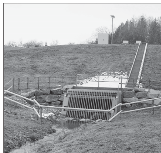
Im Volksmund heißt er der »Assuan-Staudamm«, die Hochwasserschutzmaßnahme am Dorfbach. Im Sommer hat er bereits seine erste Bewährungsprobe bestanden. swb-Bild: le
