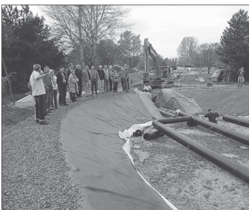
Ende September konnte in Worblingen der erste Spatenstich für das neue Naturbad vollzogen werden, die Bauarbeiten sind durch das gute Herbstwetter schon weit fortgeschritten. Der Projektausschuss für das Naturbad machte sich mehrmals ein Bild vom Stand der Bauarbeiten und verbesserte zwischenzeitlich beim Betriebsgebäude die karge Planung nach. swb-Bild: of
