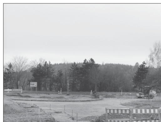
Der dritte Kreisel, an der Heilig Kreuz Kapelle, ist noch im Bau. Mit seiner Fertigstellung wird sich, so hoffen alle, die Schließung der letzten Lücke in der Radwegverbindung von Steißlingen nach Radolfzell schließen lassen.
